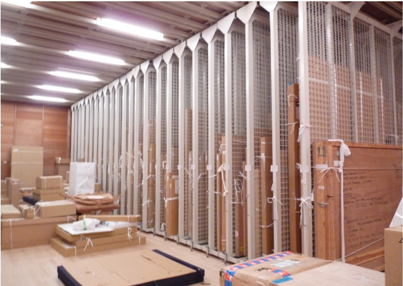
Magazyn muzealny w regionalnym mieście japońskim; widoczny sposób przechowywania każdego obiektu osobno. Ściany i podłogi wyłożone zostały specjalnym drewnem, przez co łatwiej utrzymać właściwy mikroklimat regulowany dzięki pracy dodatkowych urządzeń, Takamatsu Art Museum, 2015, fot. Monika Jadzińska
